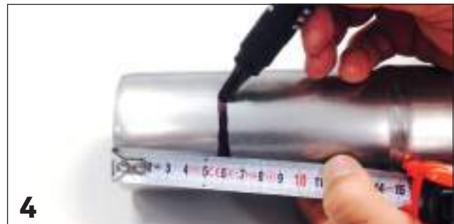
4 Marcatura quota d'innesto / Marking the insertion's depth
